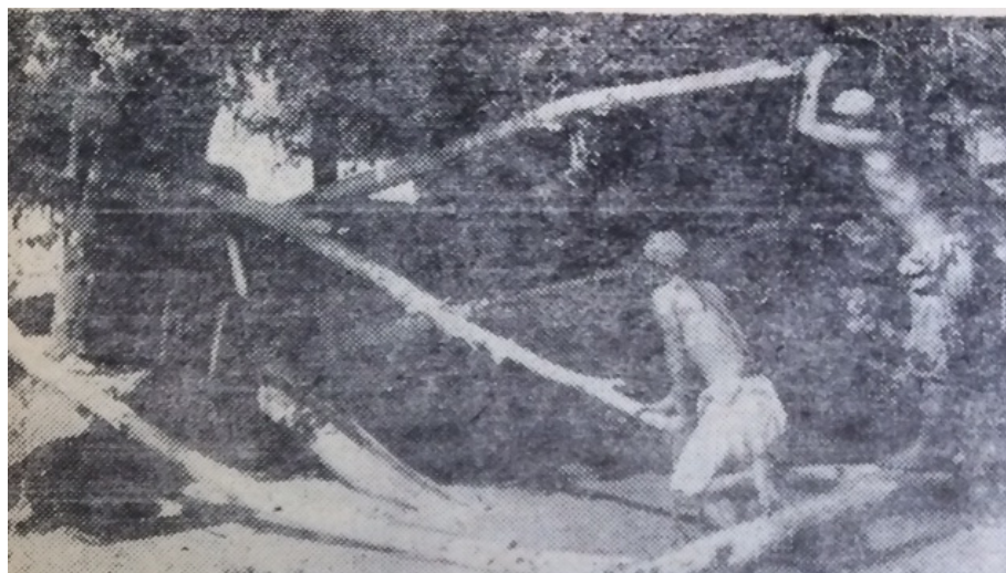
Құдық суын қолшығырмен қолмен тартып шығарудың түрікмендер және Түркіменстан қазақтары қолданған көне әдісі.
