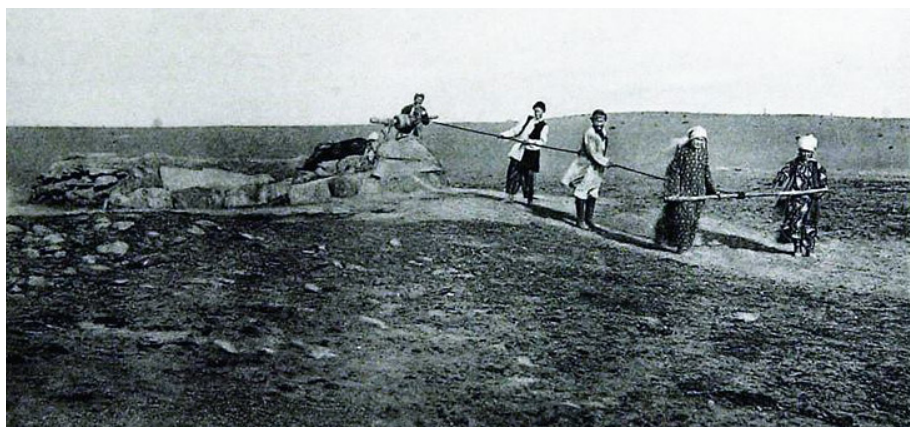
Қызылқұмда құдыққа орнатылған шығыр көмегімен қолмен су тарту. К.А. Фишер түсірген
