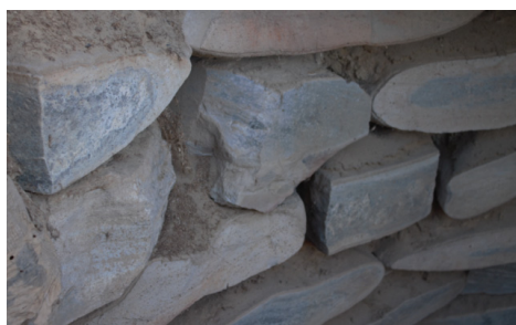
Құдық қабырғасын таспен өру түрлері. Қызылорда обл, Арал ауданы, Жалаңаш ауылы тас құдықтары қабырғасынан. Қ.орда экспедициясы
